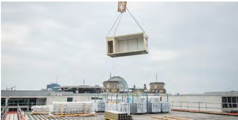
Baustelle Luisenblock West: Ein Modul wird mit einem Kran auf die Baustelle gehoben.
