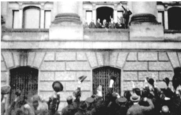
Westbalkon: Philipp Scheidemann ruft vom Balkon des Reichstagsgebäudes die Republik aus, hier in einer nachträglichen Inszenierung aus den 1920er-Jahren.
