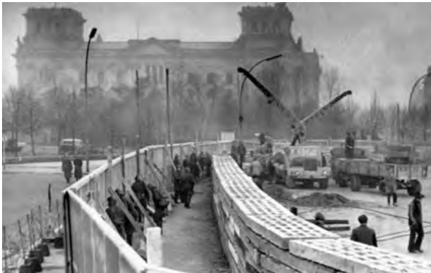
Nacht zum 20. November 1961: Hinter einer Holzwand, die als Sichtschutz dient, errichten Arbeiter auf ostdeutscher Seite eine Mauer aus Betonplatten. Im Hintergrund ist das Reichstagsgebäude zu sehen.
